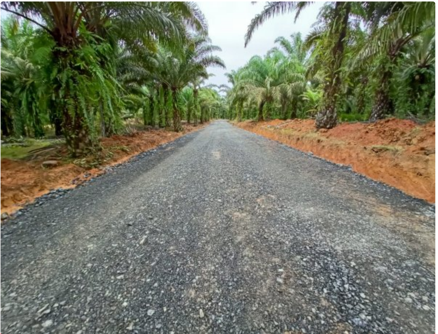
Sasaran TMMD Ke 116 Kodim 1004/Kotabaru Rampung 100 Persen
